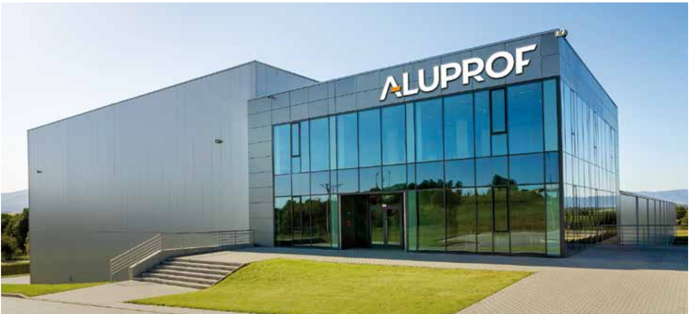
Werk in Ogródziona
